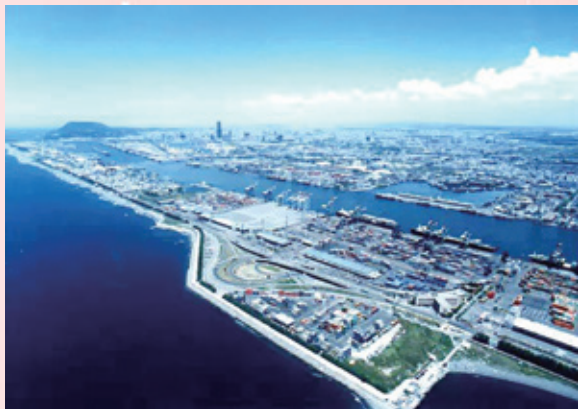
圖 2-9：高雄港空拍總圖 資料來源：高雄港務分公司網站
