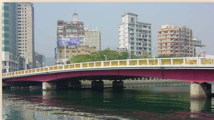
五福三路的高雄橋，是溝通鹽埕、哈瑪星與苓雅寮的要道。
