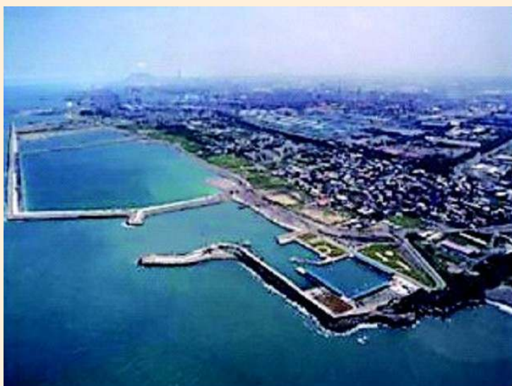
南星計畫填海造陸工程區俯視
