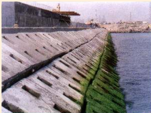
爐石和飛灰做的海堤
